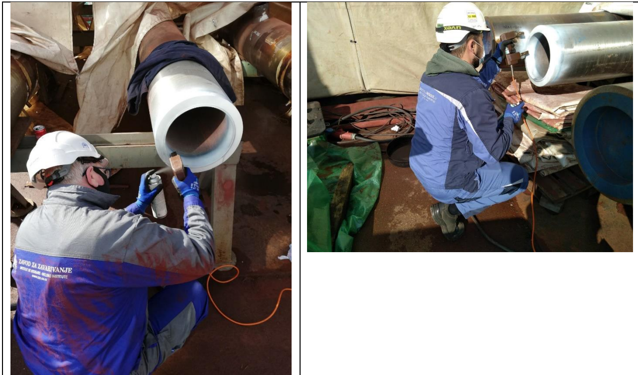
Ispitivanje magnetskim česticama krajeva cevi pre montaže i zavarivanja
